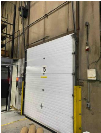
Position 15 - Dock Door
