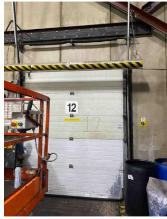
Position 12 - Dock Door
