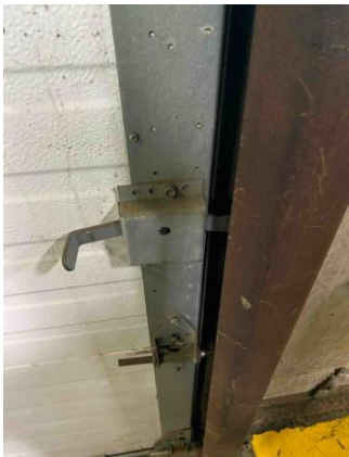
Position 14 - Dock Door
