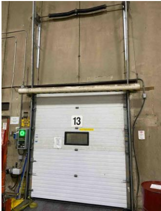
Position 13 - Dock Door
