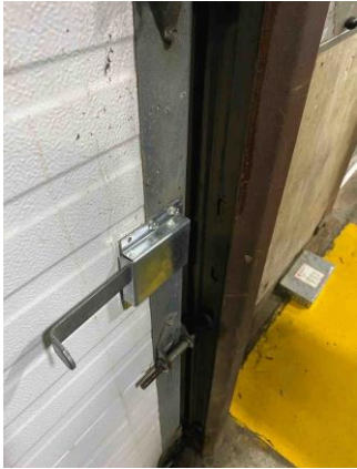
Position 14 - Dock Door
