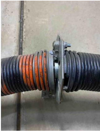
Position 15 - Dock Door
