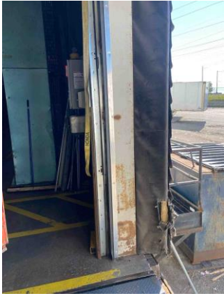
Position 10 - Dock Door
